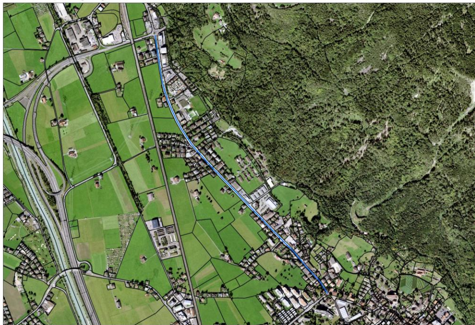
GV5.6.1 Flüelerstrasse, Altdorf: Umgestaltung
