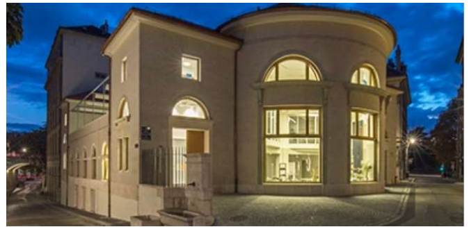
Figure 4 L'ancien manège rénové et transformé en équipement public
