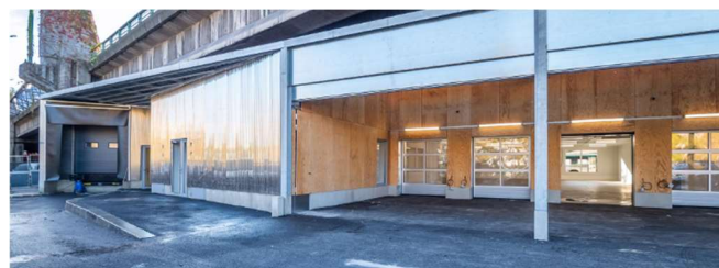
Figure 15 A l'ombre du tablier du périphérique dans le 19e arrondissement de Paris, P4, un espace de près de 800 m 2 dédié à la logistique urbaine relie Paris à la Seine-Saint-Denis. Réinvestissant un espace interstitiel jusqu'ici perdu pour la ville et ses habitants.es.
